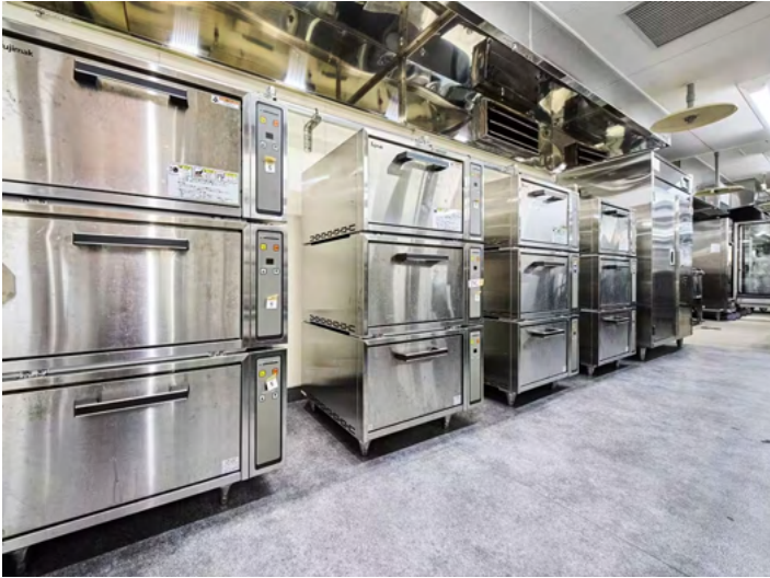
ガス式の自動炊飯器が並ぶ調理・配膳エリアの床はドライ仕様です（左写真）。 ブレイジングパンに代えて、100 リットルのバリオ大容量パンも採用いただきました（右写真）
