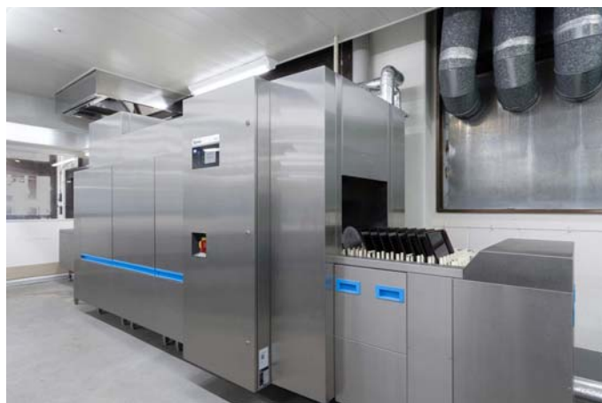
洗浄室の改装で導入した「高機能省エネ洗浄機（M-iQ）」
