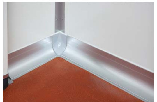
床の立ち上がりは R をつけてゴミがたまらないように施工
