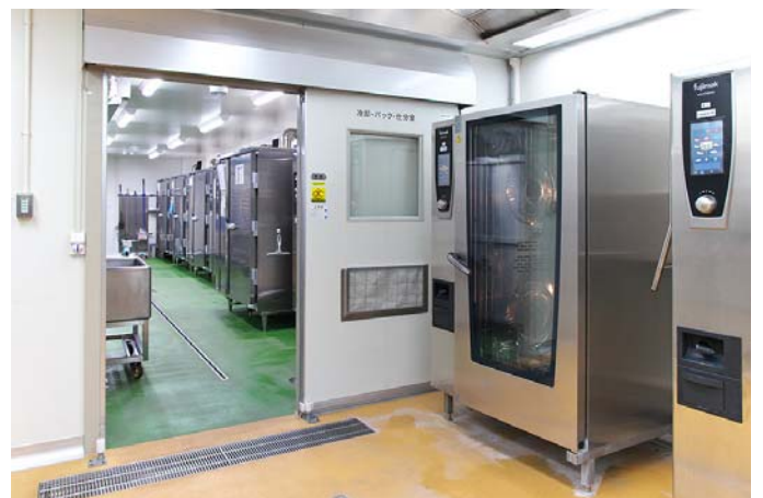
加熱エリアから見た、ブラストチラーが並ぶ冷却エリア
