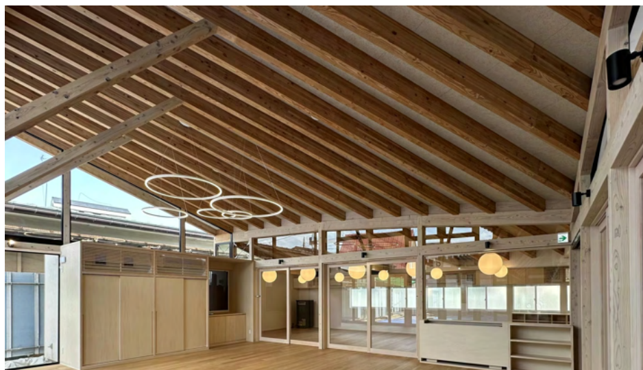
新園舎のホール。丸をモチーフとした照明や、高い天井を支える太い梁が特徴的です（提供：くりのみ保育園）
