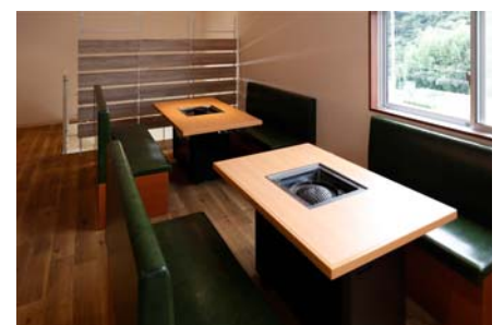
無煙ロースターを設置した、店舗 2 階のダイニングスペース
