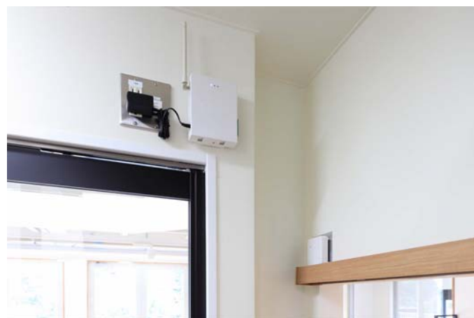
厨房内の中継機（左）と温湿度センサー（右）
