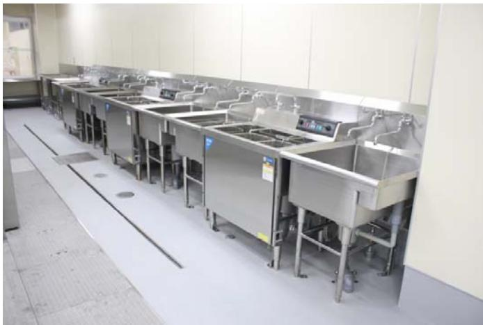
洗浄ラインは、食缶、トレイ、食器、コンテナ、小物類で区別。上洗浄と下洗浄、汚染区域と非汚染区域がはっきり分かれています。導線が交差することなく衛生的。洗浄・乾燥された食器などは非汚染区域で保管。
